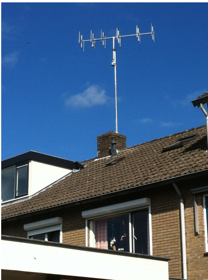
De 6-Elements Quad antenne
